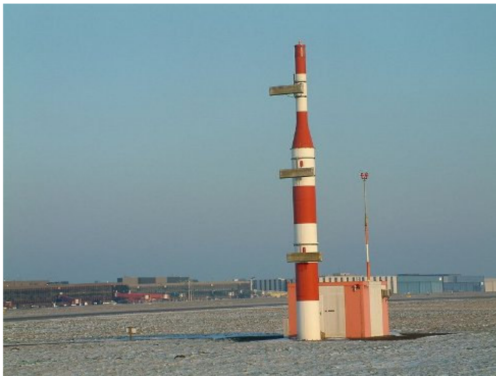
Stacja nadajnika ścieżki schodzenia systemu ILS na lotnisku w Hanowerze (fot. Herr-K/de.wikipedia)
