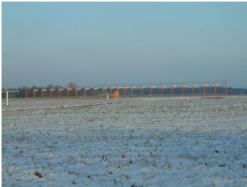
Anteny Localizera systemu ILS na lotnisku w Hanowerze (fot. Herr-K/de.wikipedia)
