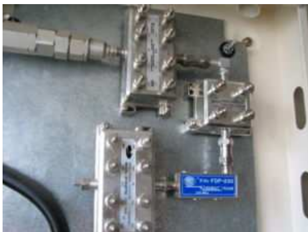
Przykład skrzynki z zamontowanym filtrem dolnoprzepustowym
